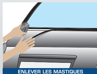
ENLEVER LES MASTIQUES
